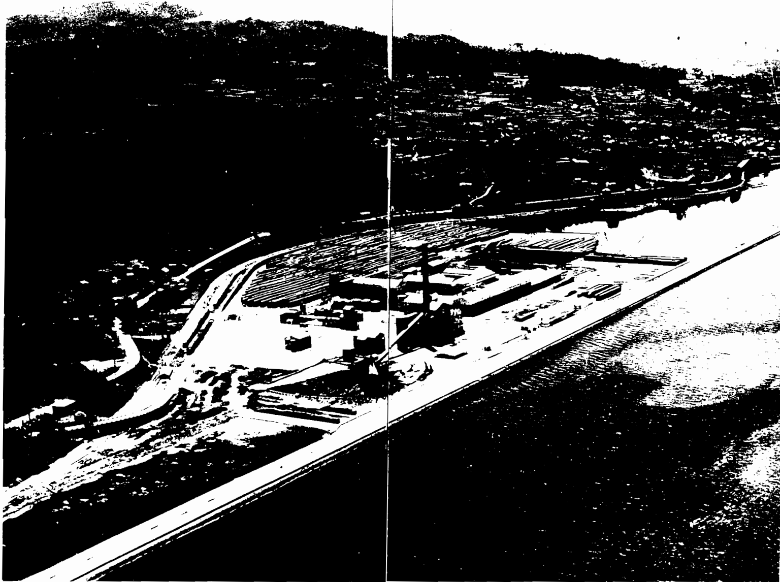
Foto 2. Vista aérea de la factoría en sus primeros años. Se puede apreciar la importante cantidad de terreno ganada al mar, y la posibilidad de incrementar aquel gracias a la escasa profundidad de la ría. Al comenzar los trabajos de dragado de la zona se produjeron los enfrentamientos con las mariscadoras y vecinos de las parroquias adyacentes. A la izquierda del parque de madera se observa, casi inapreciable, la pista de acceso al Centro Forestal de Lourizán. Fuente: Boletín Informativo del PFE , 2, 1964, pp. 18-19.
