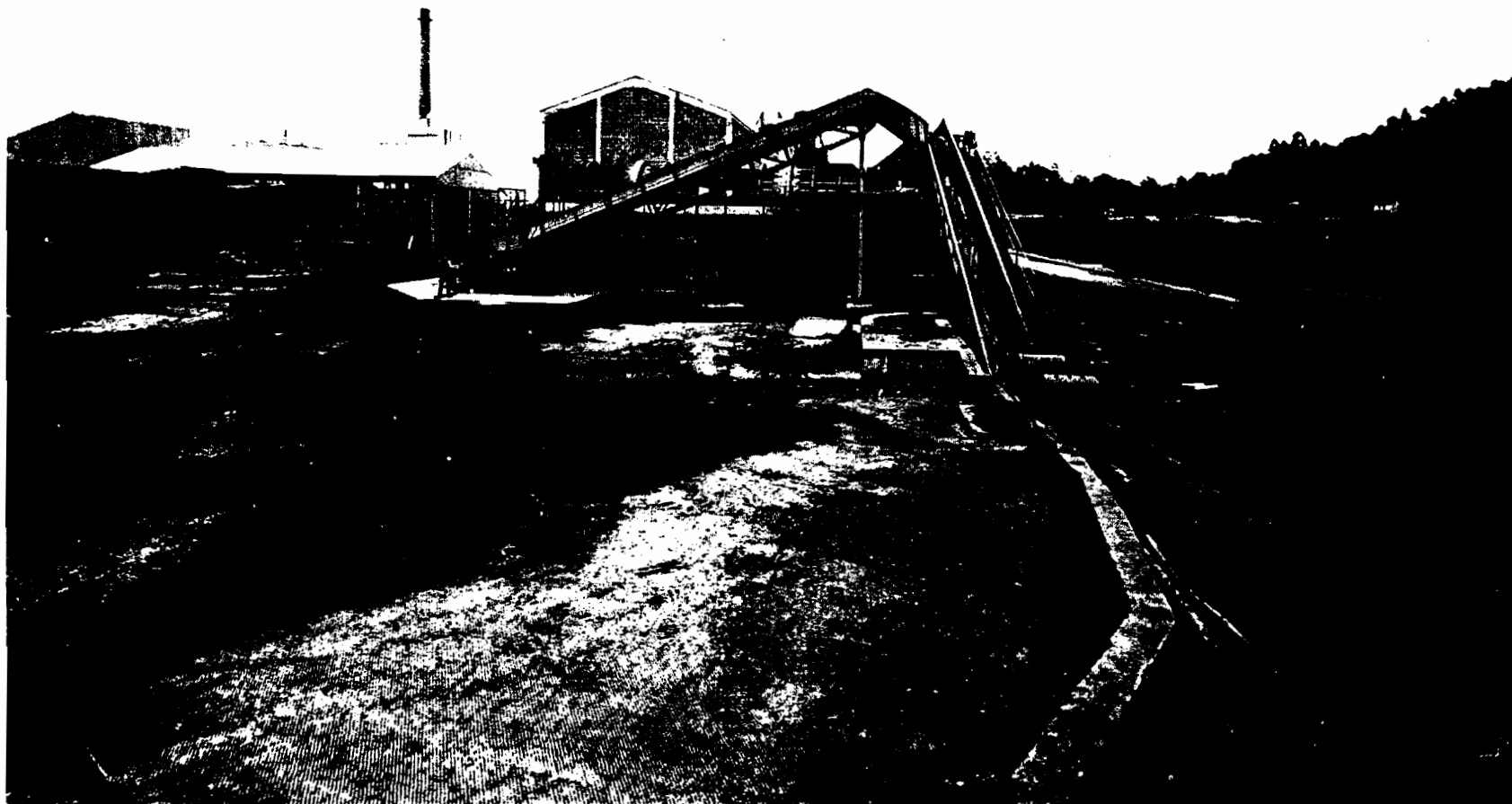
Foto 5. Otra perspectiva de la factoría. En este caso vemos el tambor de descortezado de la madera. La maquinaria principal y los componentes más sofisticados solían adquirirse en el exterior, a diferentes casas constructoras, por ejemplo, la Stein Roubaix o la Société Française Whiting Fermont. Fuente: Boletín Informativo del PFE , 2, 1964, p. 21.
